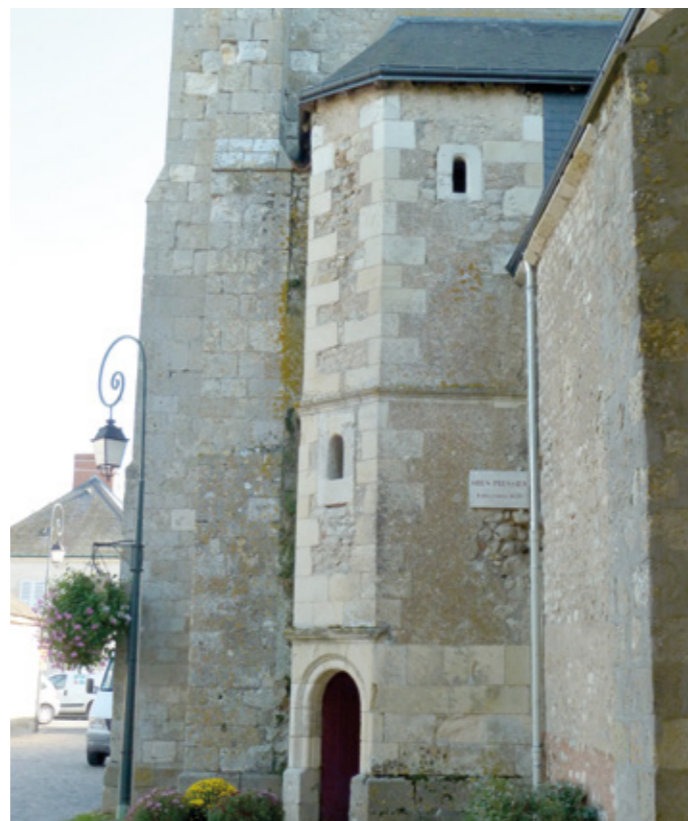
6. Tourelle d'accès au clocher
