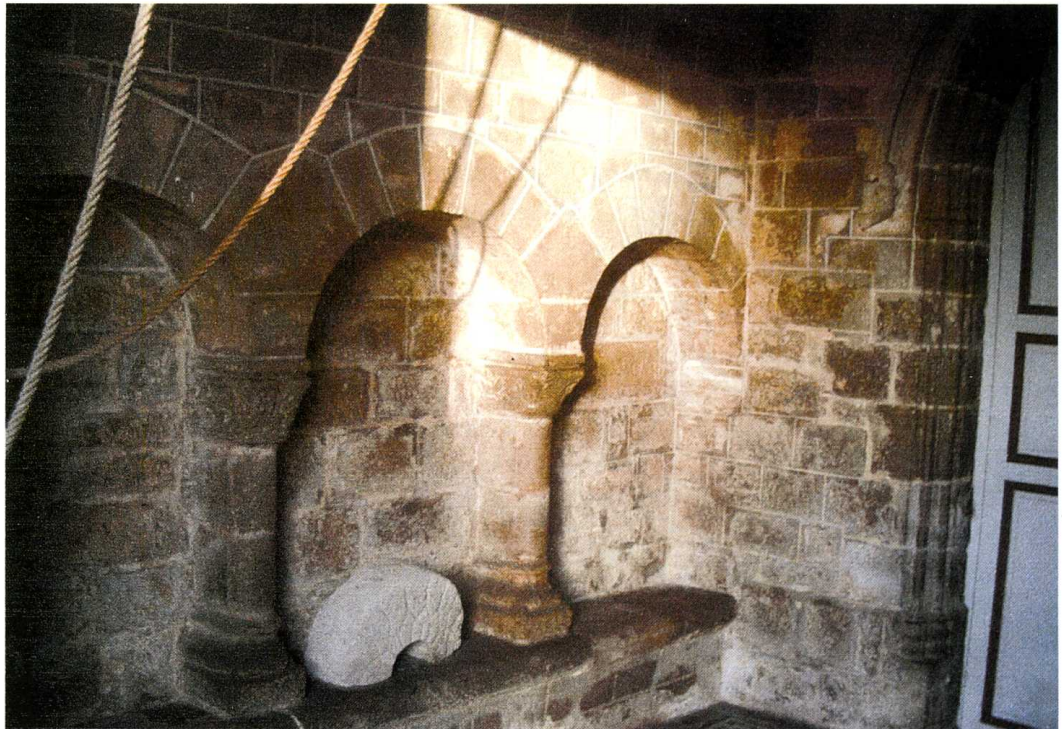
Mareau-aux-Bois (Loiret) Église Saint-Georges Arcature à l'intérieur du porche
