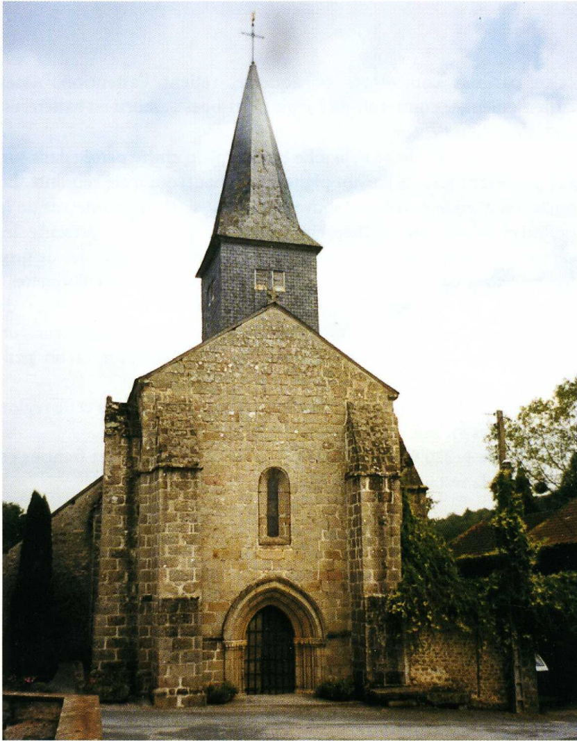
Marsac (Creuse) Église Saint-Pierre-et-Saint-Paul Façade occidentale
