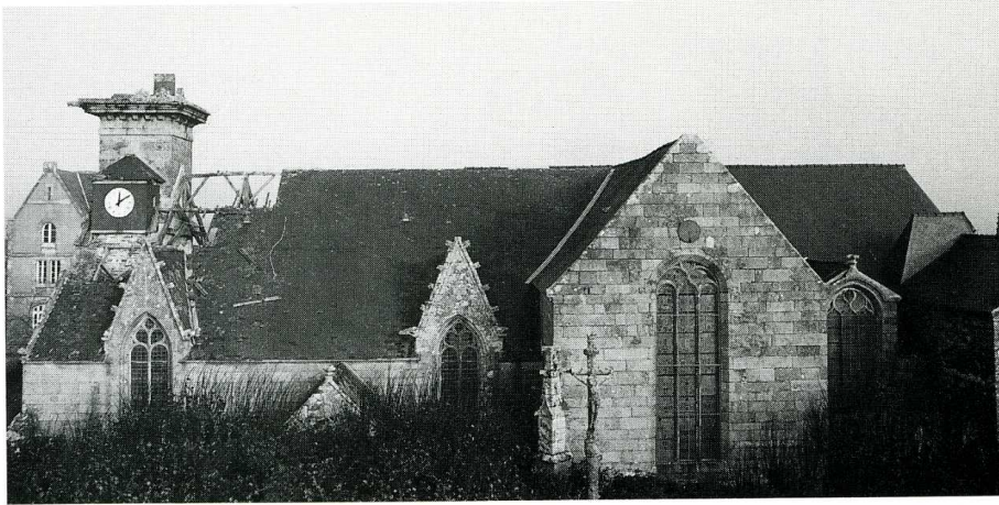
Melgven (Finistère). Église Saint-Pierre et Saint-Paul, après l'écroulement du clocher en 1987.
