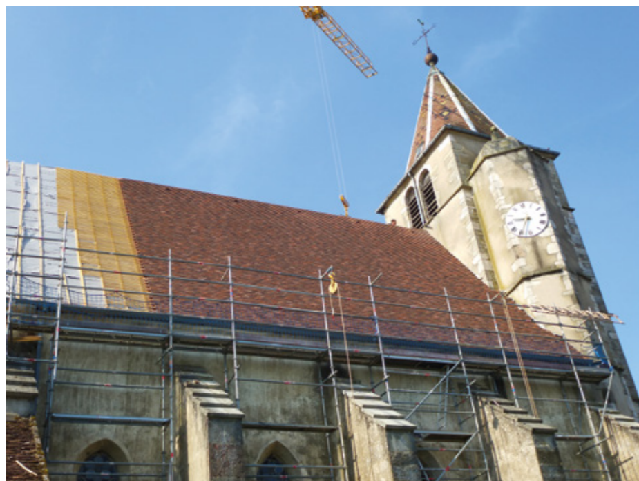
5. Couverture en cours de restauration
