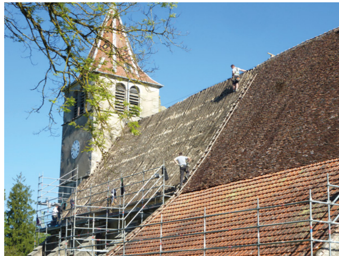
4. Couverture en cours de travaux
