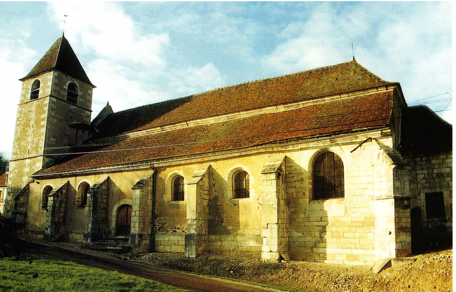
Merry-Sec (Yonne) Église Saint-Menge Façade sud (cl. H. Cazelles, arch.)
