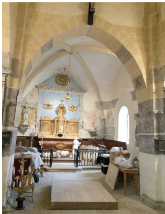
6. Chœur en cours de restauration
