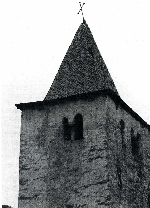
Miglos-Arquizat (Ariège). Église Saint-Hilaire, clocher avant travaux.
