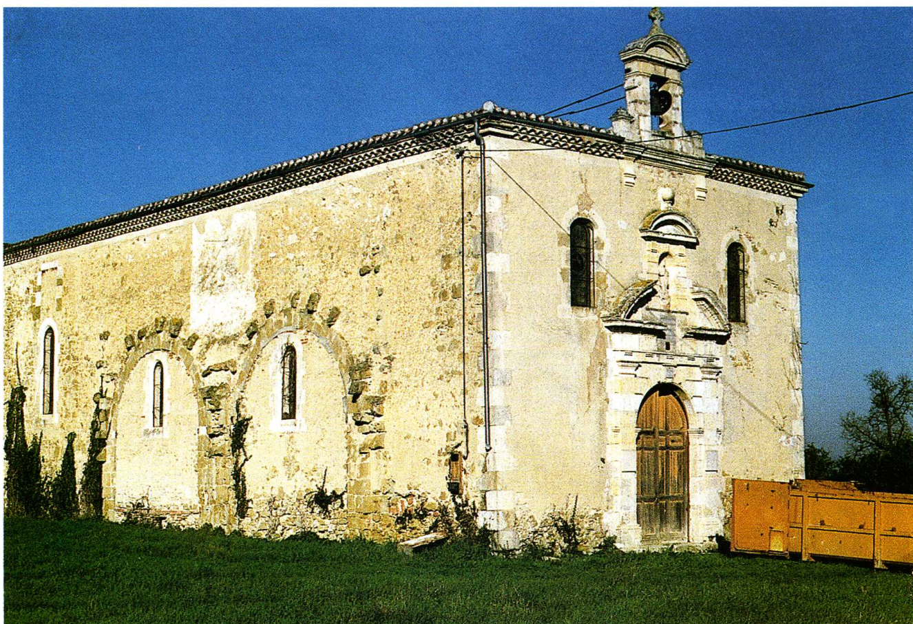
Miramont-Latour (Gers) Chapelle Notre-Dame des Anges Façade occidentale
