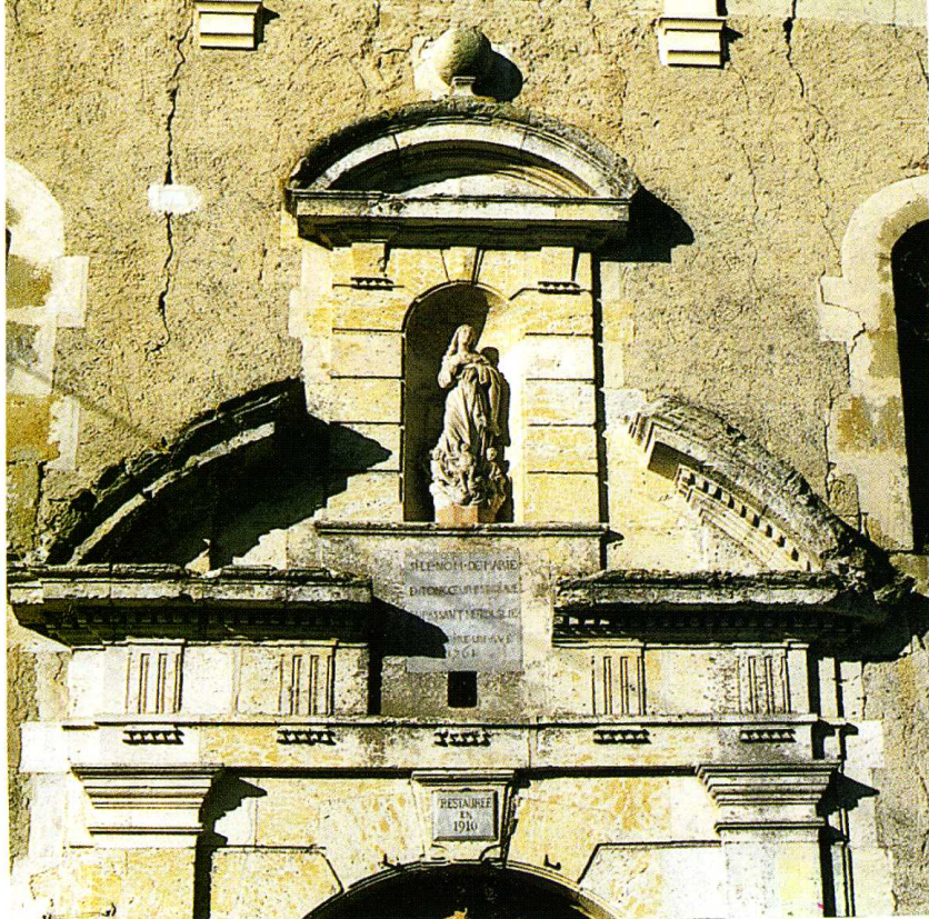
Miramont-Latour (Gers) Chapelle Notre-Dame des Anges Détail de la porte d'entrée
