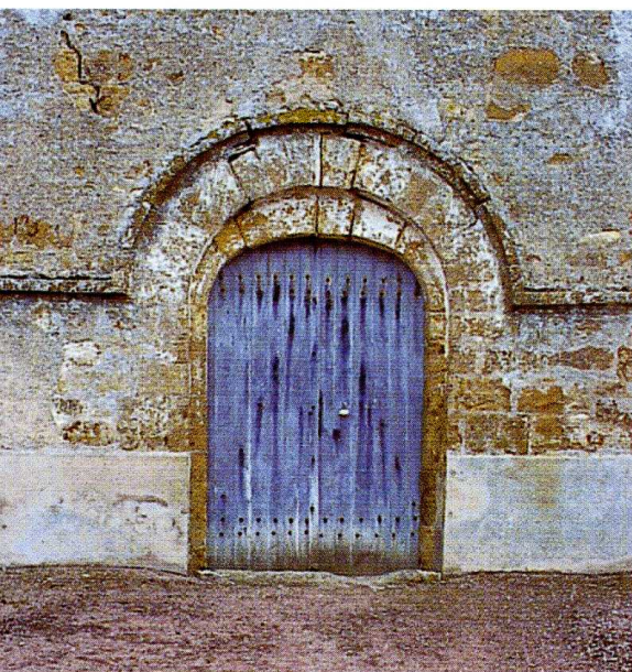
Moissy-Moulinot (Nièvre) Église Notre-Dame 1. Façades sud et ouest 2. Porte occidentale
