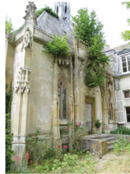
2. Façade occidentale de la chapelle
