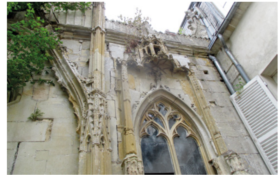
3. Piédroit du portail central et l'une des fenêtres latérales : éléments du xv e siècle en remploi
