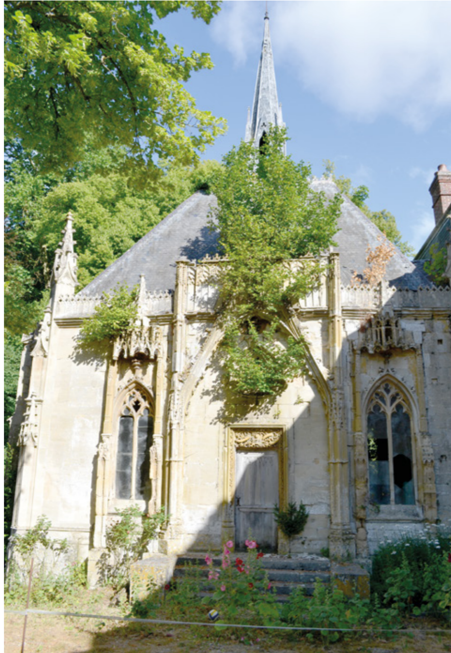
1. Façade occidentale de la chapelle, avec les éléments en remploi de l'église des Grands Carmes de Metz, avant restauration
