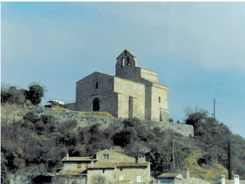
Montclar-sur-Gervanne (Drôme) Église Saint-Marcel
