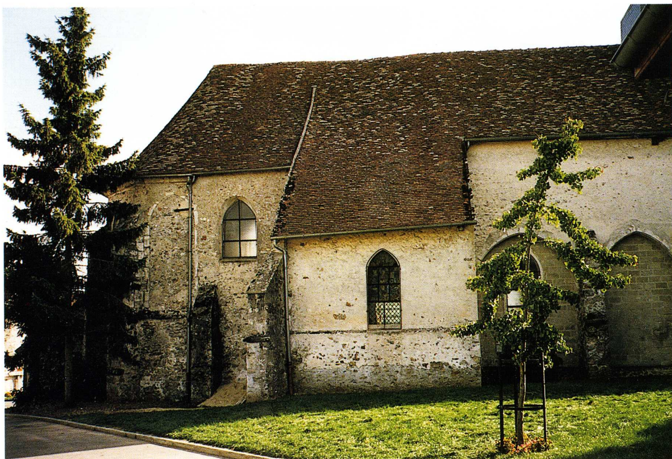
Montdauphin (Seine-et-Marne) Église Saint-Loup Façade nord avec le chevet, la chapelle et le collatéral disparu
