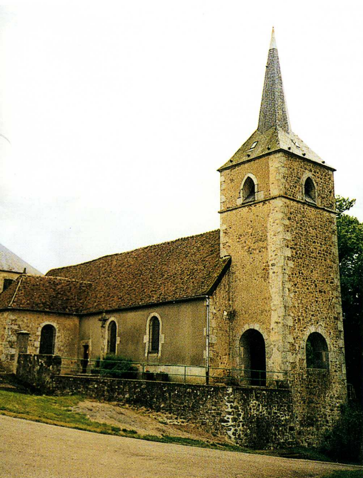
Montigny-en-Morvan (Nièvre) Église Saint-Léger Vue du nord-ouest
