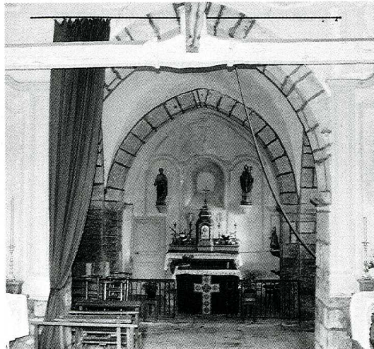
Montigny-Saint-Barthélemy (Côte-d'Or). Église Saint-Barthélemy. Église avant restauration et vue intérieure vers le chœur.
