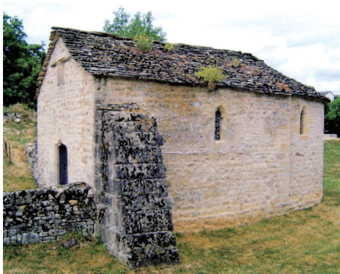
Montrodat (Lozère) Chapelle Saint-Jean Façades sud et ouest
