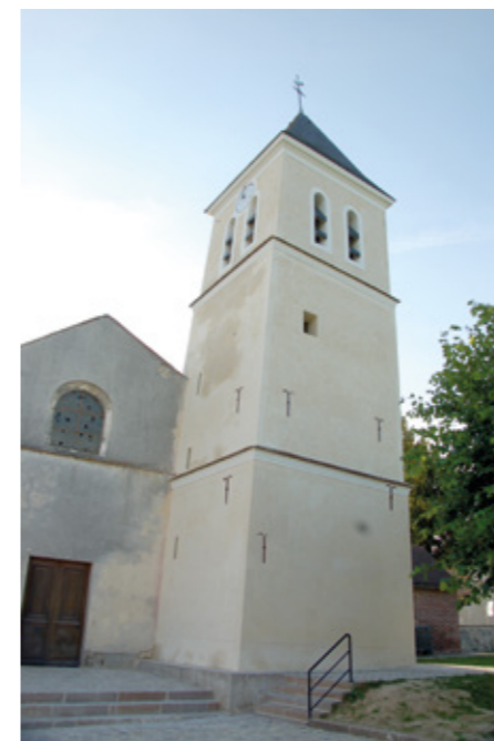
5. Clocher après restauration
