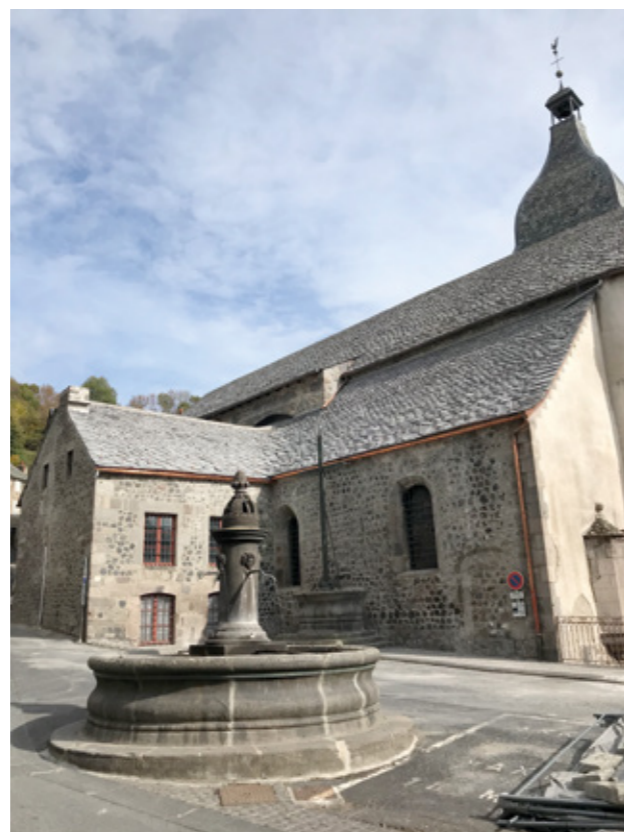
8. Façade nord après travaux
