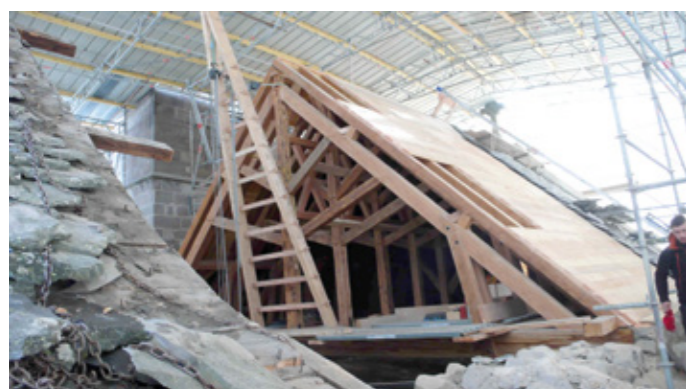
7. Reconstruction de la charpente
