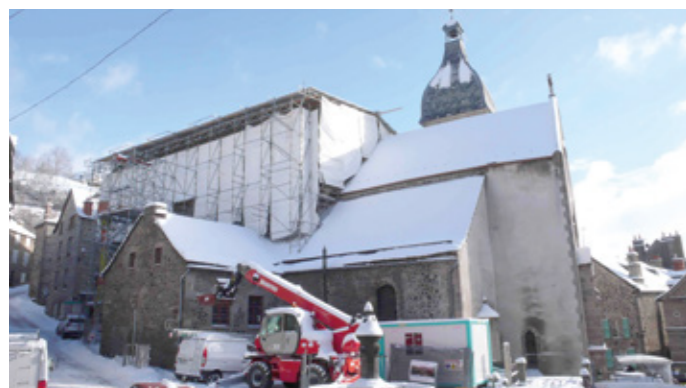
6. Église en cours de restauration
