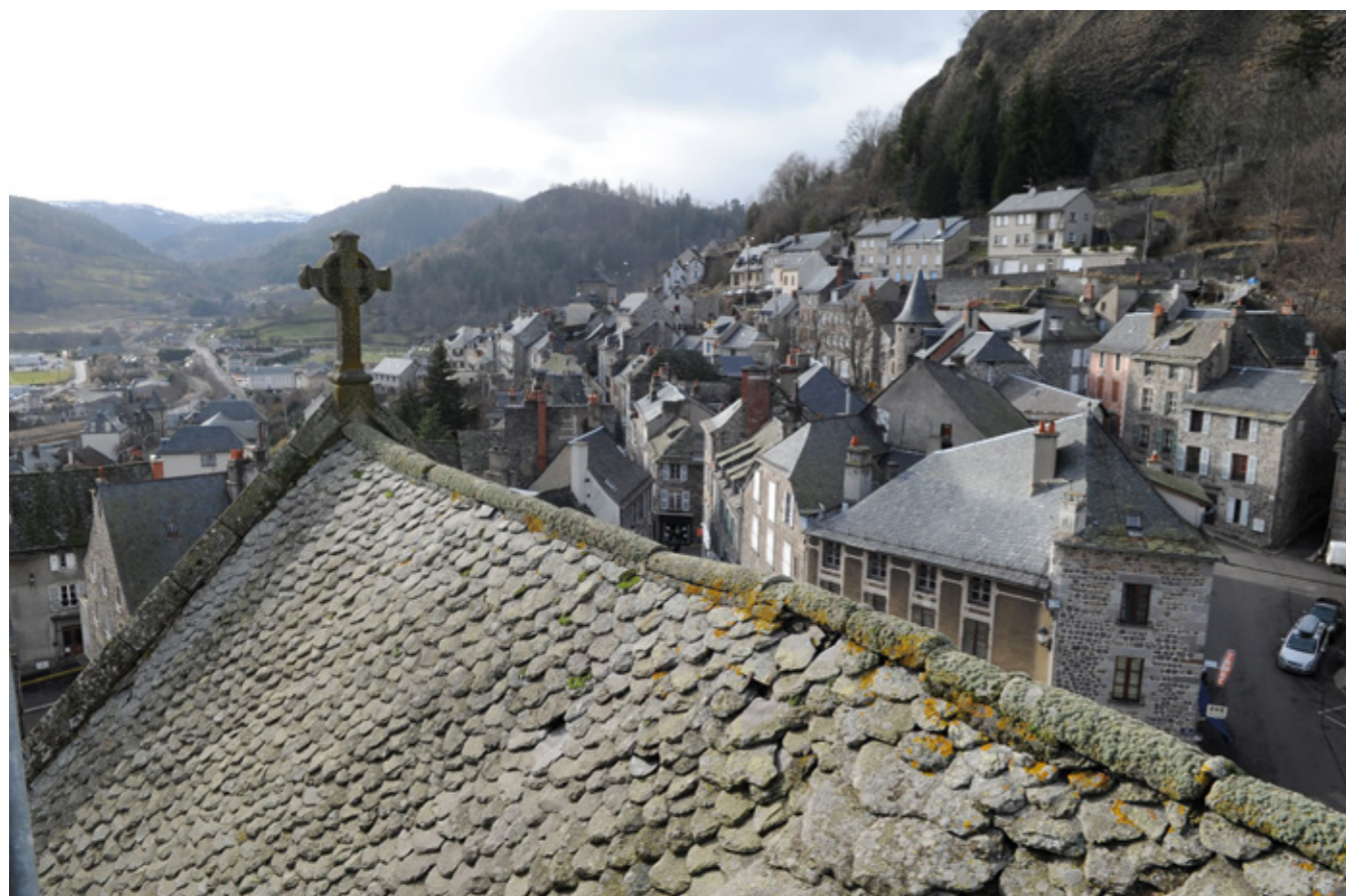
5. Toiture en lave avant restauration
