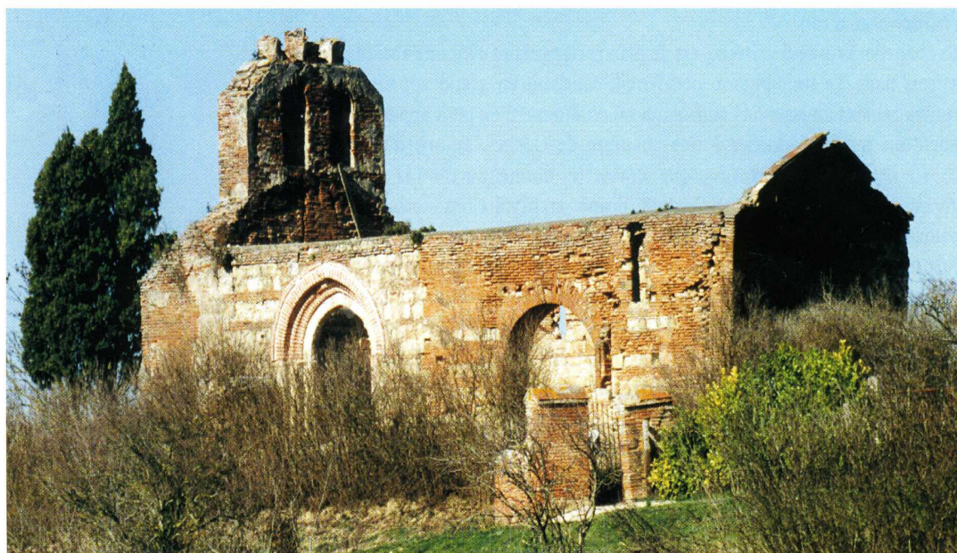
Muret (Haute-Garonne) Chapelle Saint-Amans 1. Façade sud avant travaux (cl. H. Ameglio, 1998)
