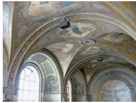
3. Voûtes de la nef et du chevet
