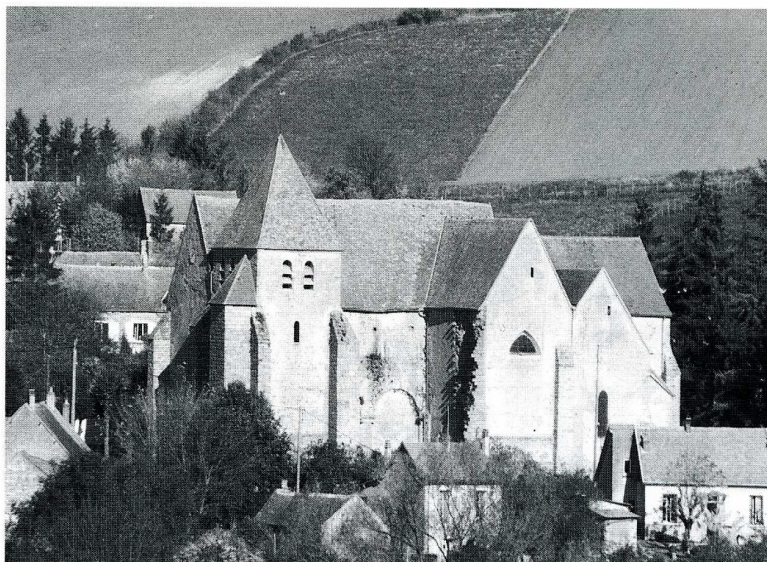
Nailly (Yonne). Église Saint-Pierre, vue côté sud.
