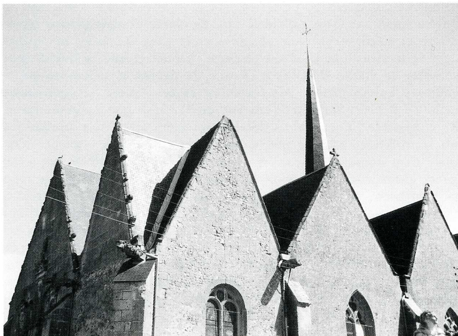
Neuillé-Pont-Pierre (Indre-et-Loire), église Saint-Pierre, façade sud-ouest (juillet 1993).
