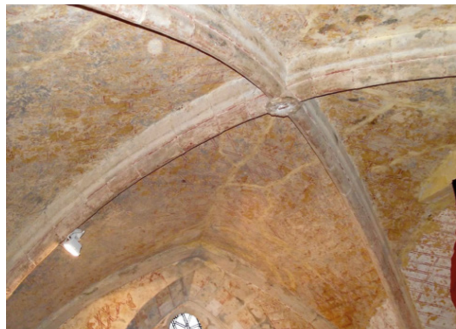
3. Vue intérieure de la voûte du chœur
