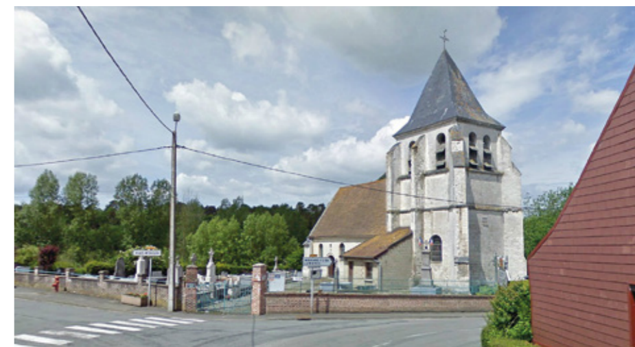
2. Vue générale de la façade sud-est
