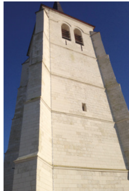
3. Tour-clocher après restauration
