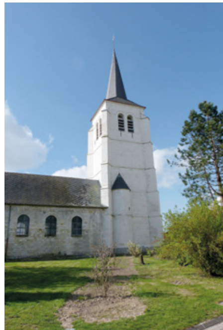
1. Vue de la tour-clocher après restauration
