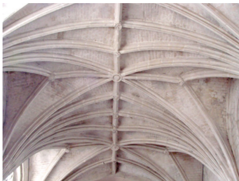
5. Détail de la voûte de la nef
