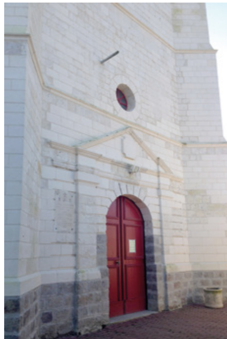
2. Détail de la tour-clocher de la façade occidentale après restauration
