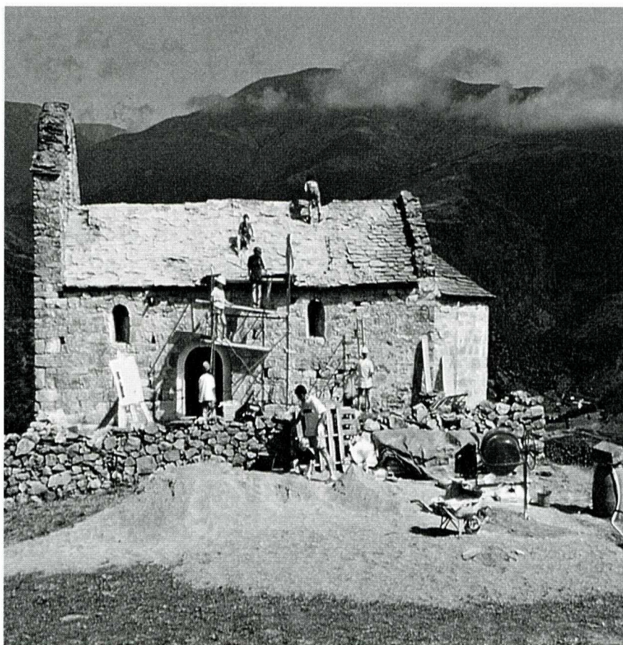
Nyer (Pyrénées-Orientales). Église Saint-Just-Saint-Pasteur. Façade sud au cours des travaux.
