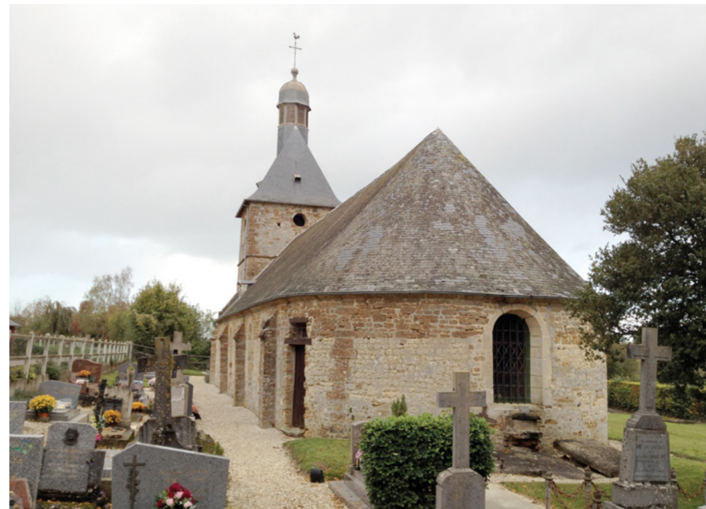
1. Vue d'ensemble de l'église depuis l'angle sud-est
