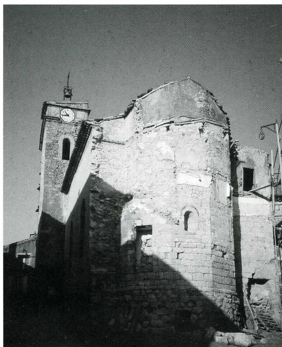
Pailhès (Hérault), église Saint-Étienne. 1. Vue de l'édifice depuis l'est. 2. Chevet. 3. Chevet de l'église avec la fenêtre d'axe.
