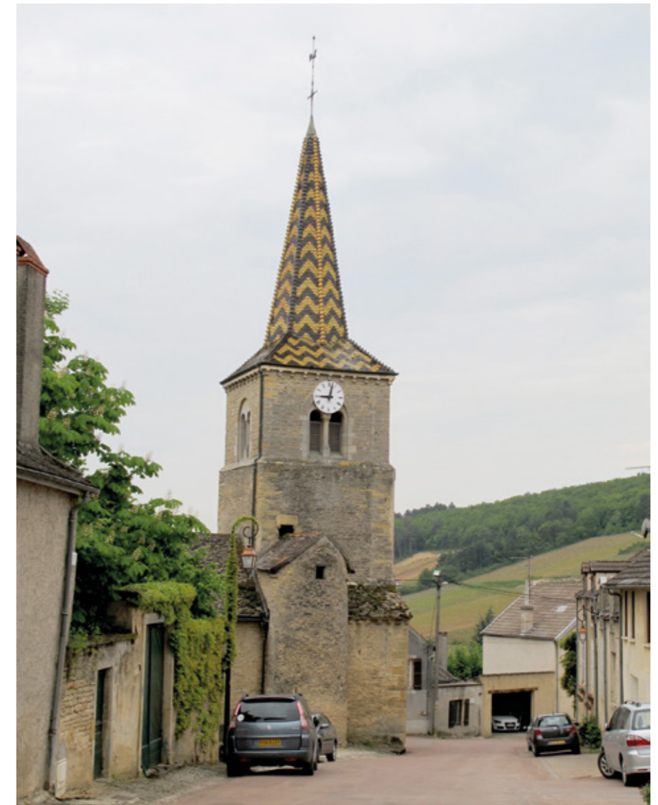
2. Façade nord du clocher
