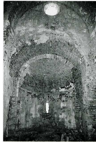
Les Plantiers (Gard). Église Saint-Marcel de Fontfouilhouse, intérieur du chœur.
