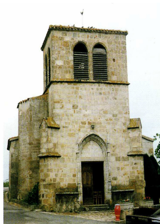
2 Pralong (Loire) Église Saint-Romain 2. Façade occidentale
