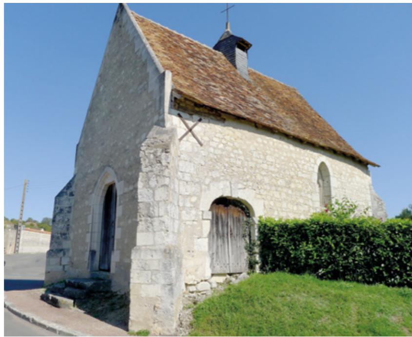
4. Vue sud-ouest avant travaux
