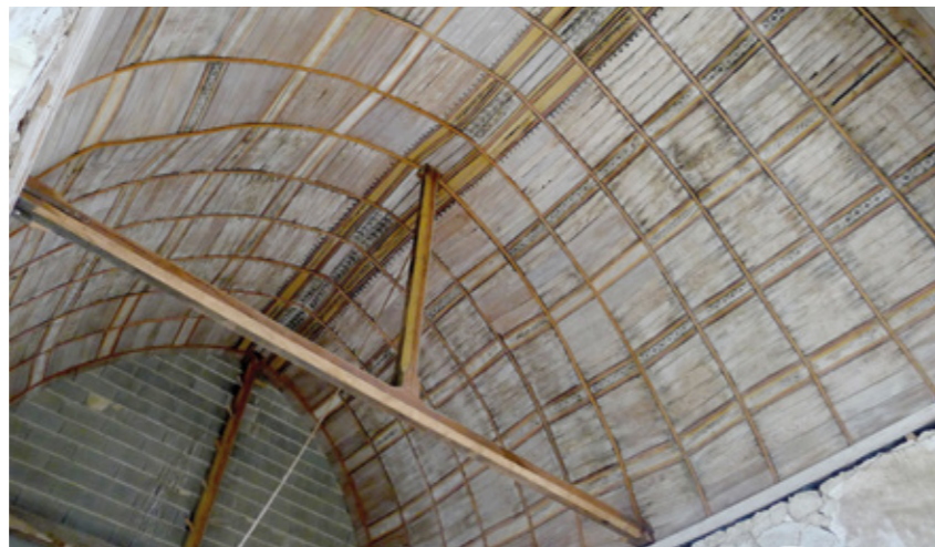
6. Charpente lambrissée après travaux
