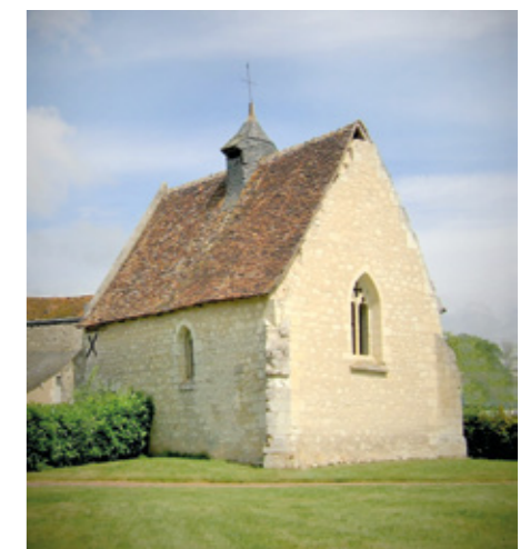
1. Vue sud-est avant travaux
