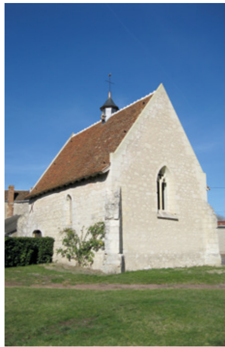
3. Vue sud-est après travaux
