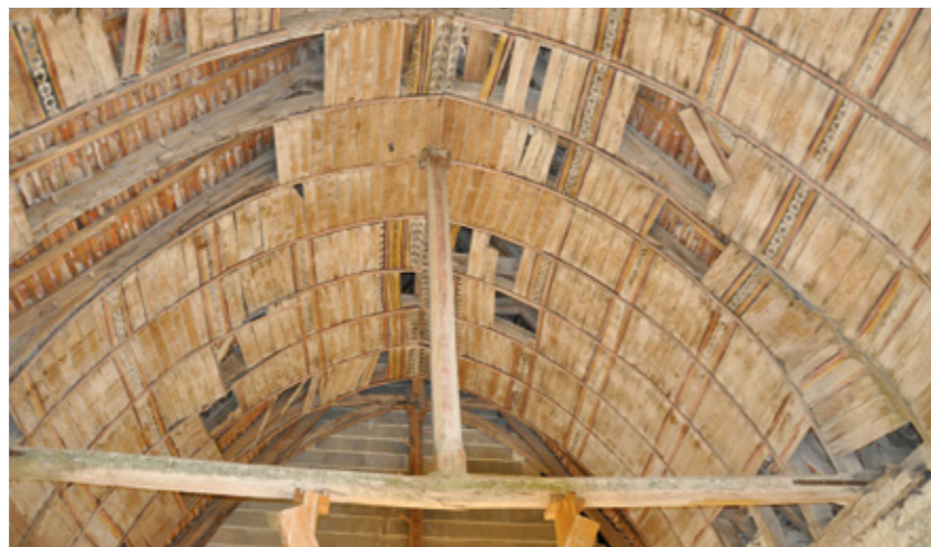
5. Charpente lambrissée avant travaux
