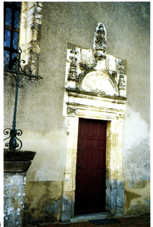
Préval (Sarthe) Église Saint-Pierre-et-Saint-Paul 3. Porte du bas-côté nord
