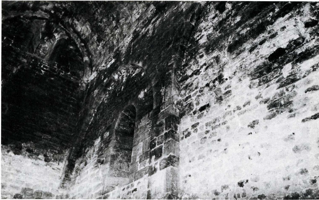
15. Détail du mur sud à l'intérieur. Cl. J. Huguet.
