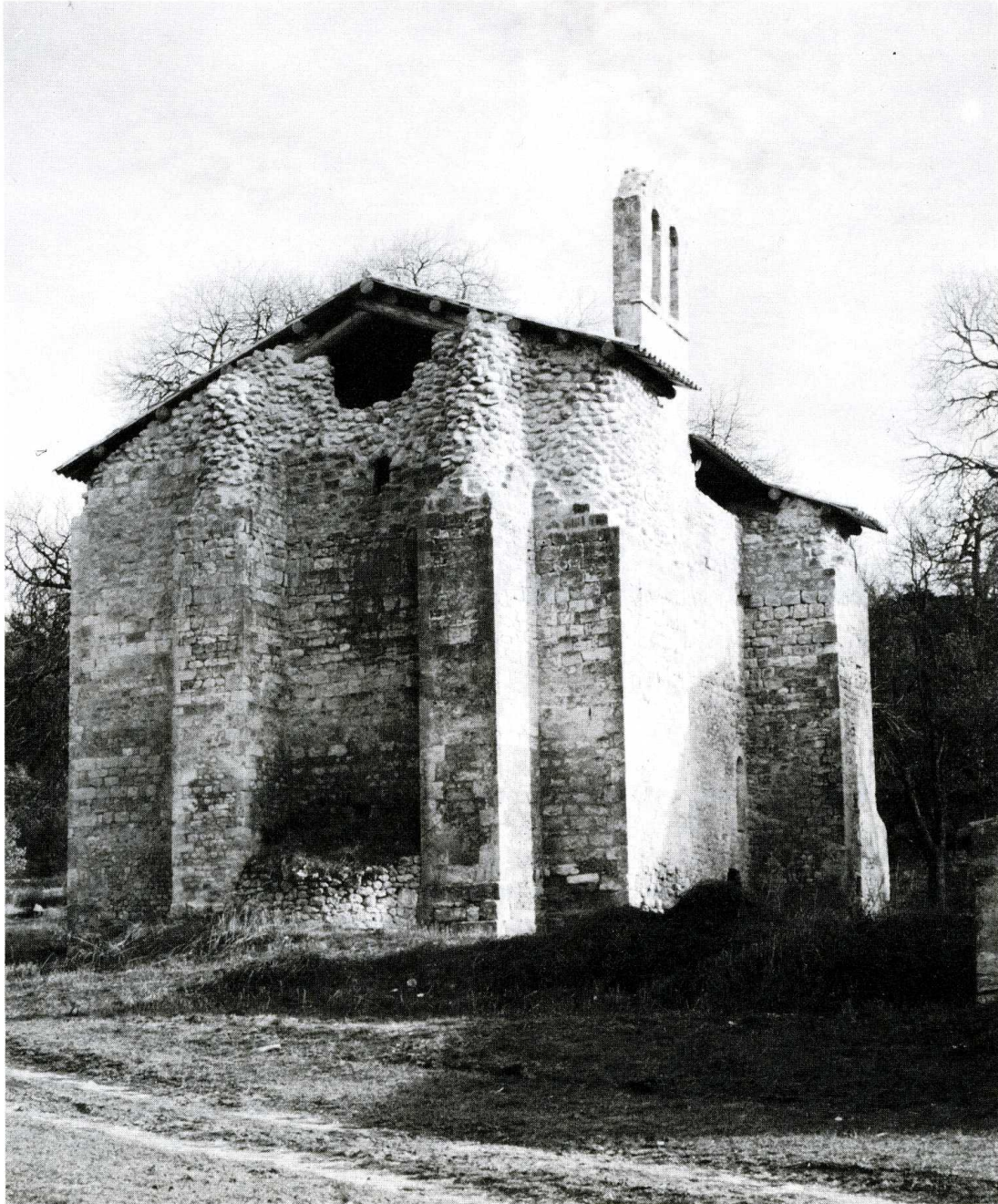
8. Vue extérieure après restauration en 1985.
