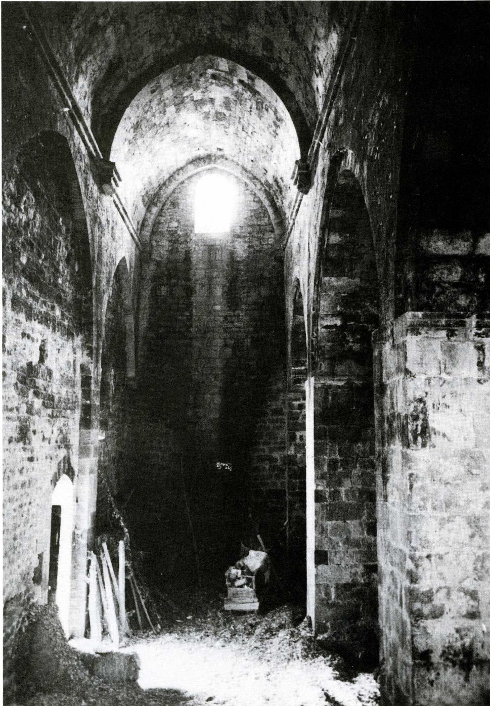
4. Vue intérieure de la nef vers l'ouest. Cl. J. Huguet.
