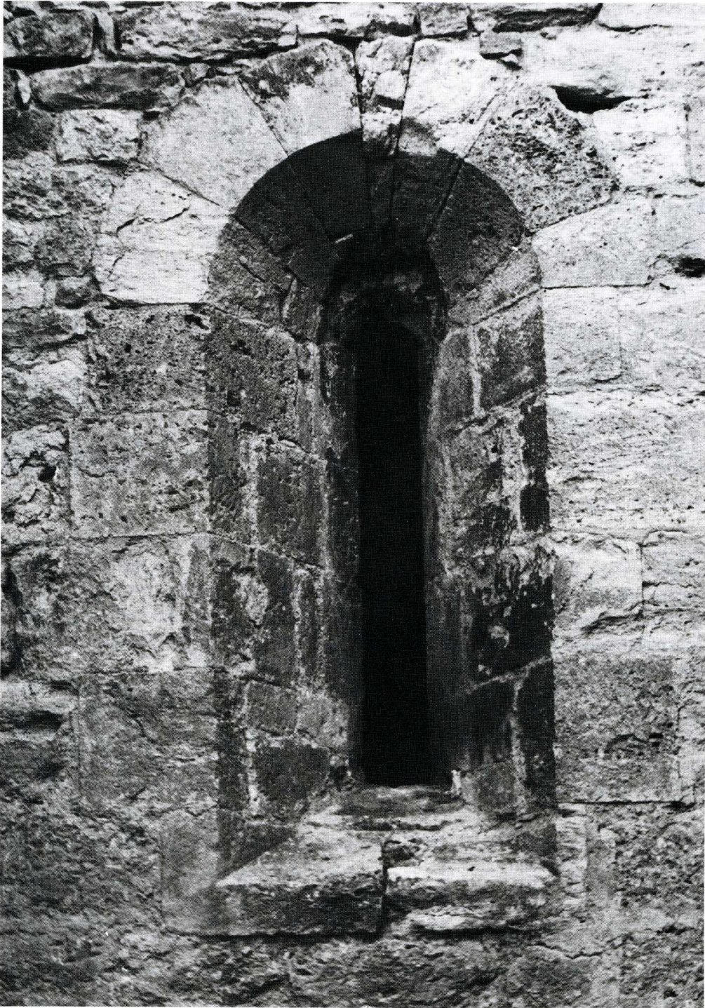
16. Baie du mur nord.
