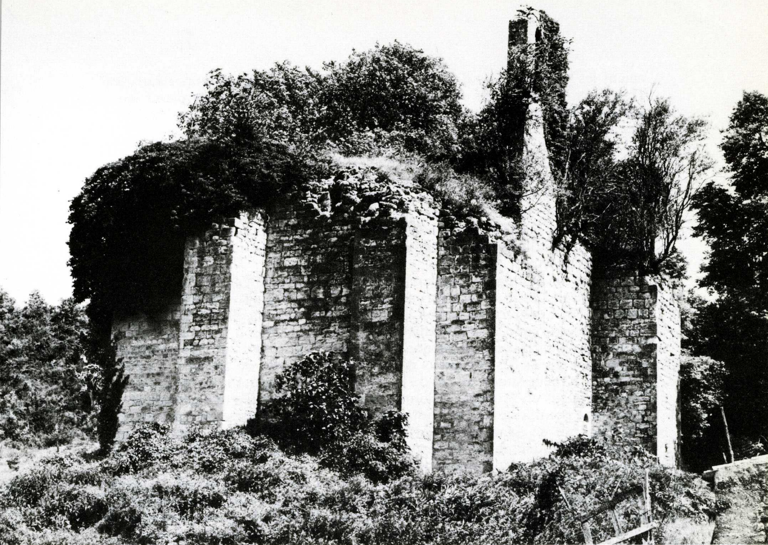
1. Saint-Apollinaire de Puimoisson avant restauration. Cl. R. Volland.
