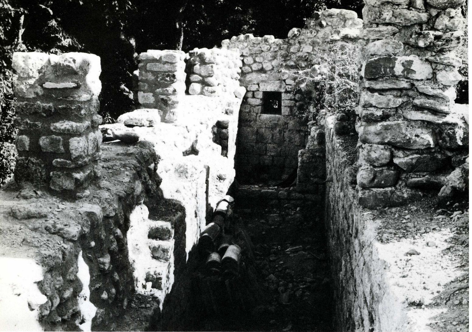
9. Galerie dégagée au-dessus des voûtes des chapelles nord en 1983. Cl. R. Voland.
