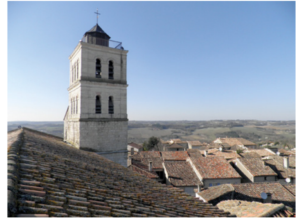
1. Couverture de la nef et de la tour-clocher
