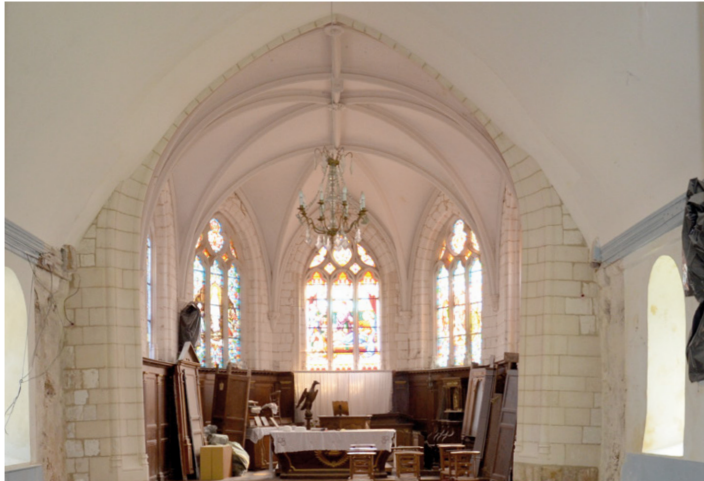
4. Vue intérieure vers le chœur avant restauration
