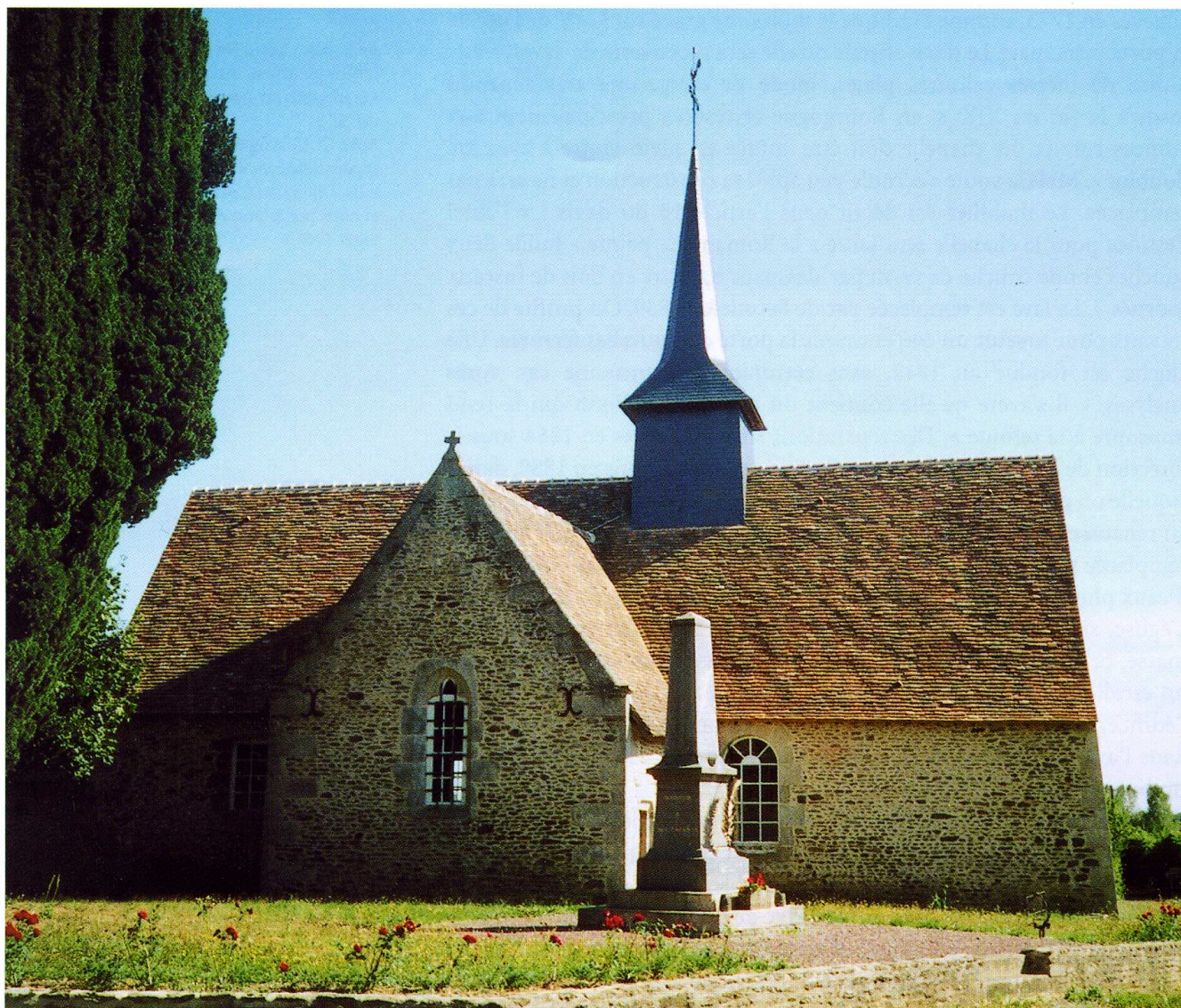
Ravigny (Mayenne) Église Saint-Julien 1. Vue du nord après restauration
