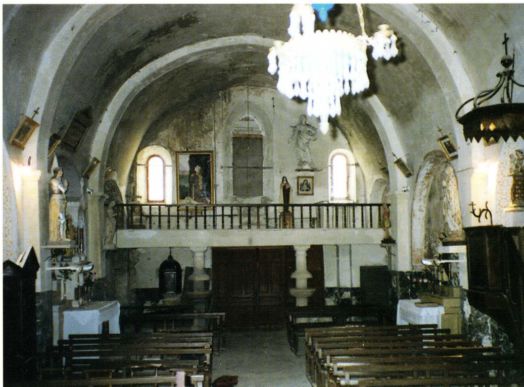
Réauville (Drôme) Église Vue de la nef vers l'ouest
