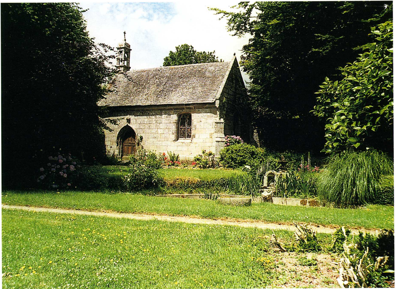
Le Relecq-Kerhuon (Finistère) Chapelle de Lossulien Façade sud avant travaux
