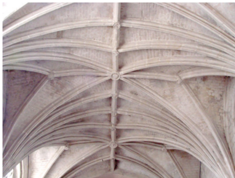
5. Détail de la voûte de la nef
