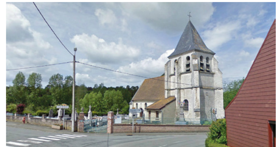
2. Vue générale de la façade sud-est
