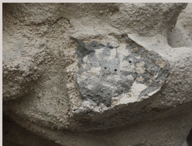
5. Le collage au ciment s'est rompu et le fragment est perdu
