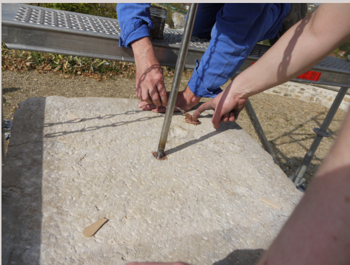
3. Positionnement des plots de colle
