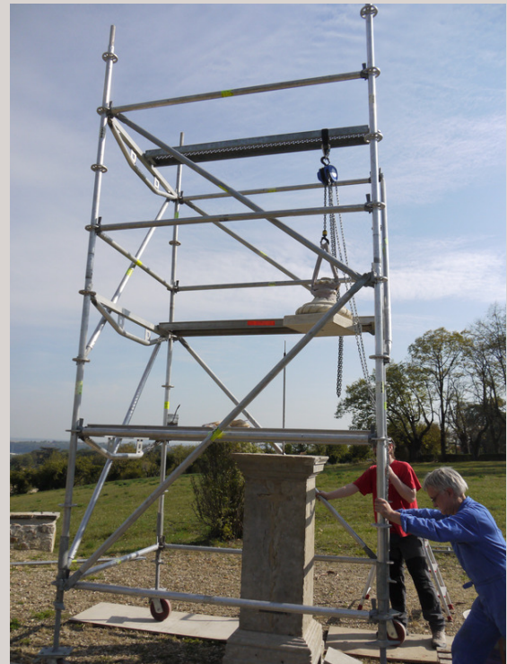
2. Positionnement du piédestal
