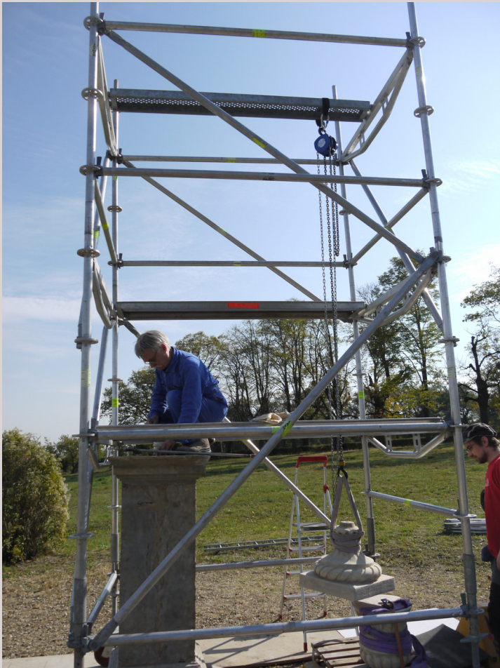
1. Mise en place de l'échafaudage et hissage du piédestal
