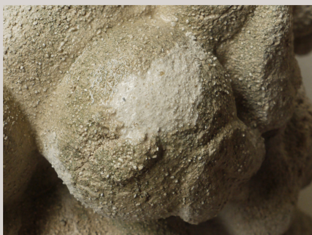
3. Après application du mortier de chaux
