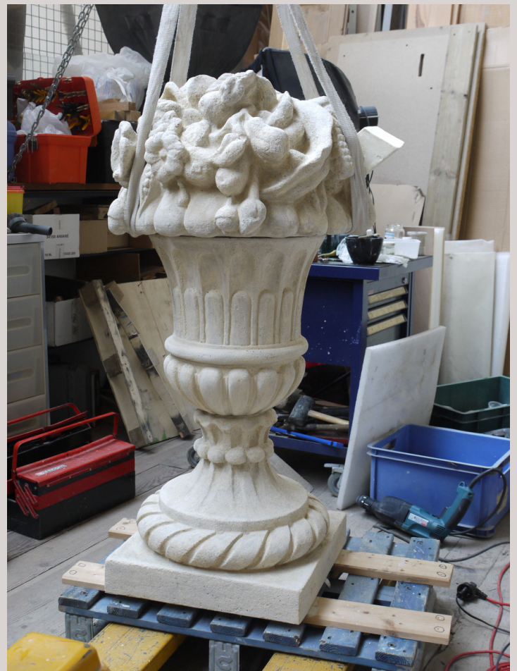
Après application du badigeon et de l'hydrofuge
