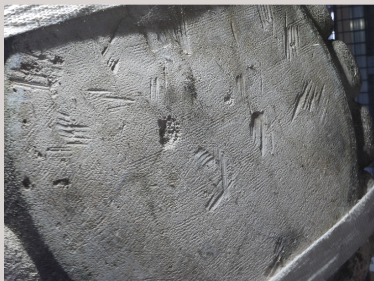
Traces d'outils de taille sous la corbeille
