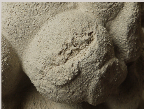
1. Exemple de zone à mastiquer
