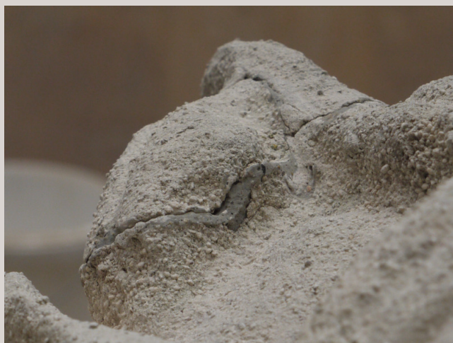
1. Mise en évidence de réparations anciennes
