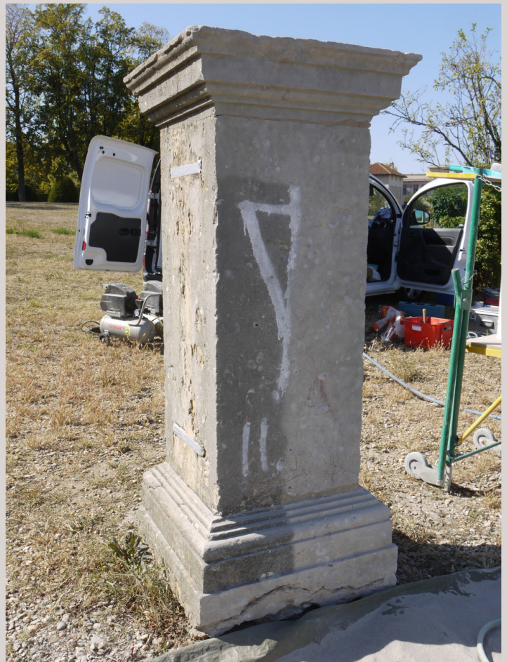
Nettoyage de l'épiderme par microsablage
