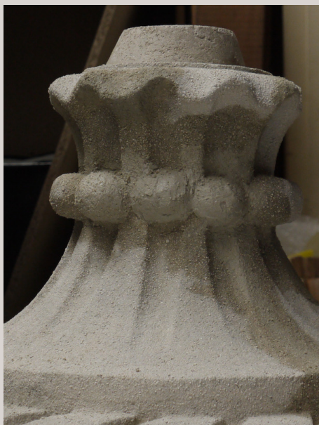
Les boules manquantes en cours de restitution
