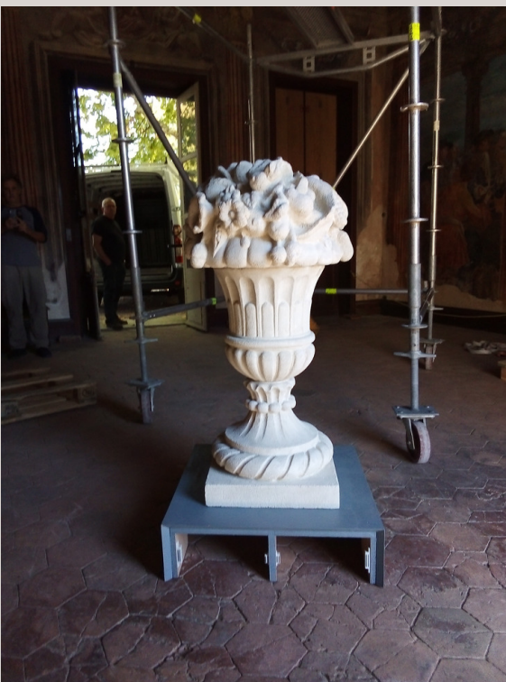
3. Le vase est positionné sur le piédestal grâce à un échafaudage roulant
