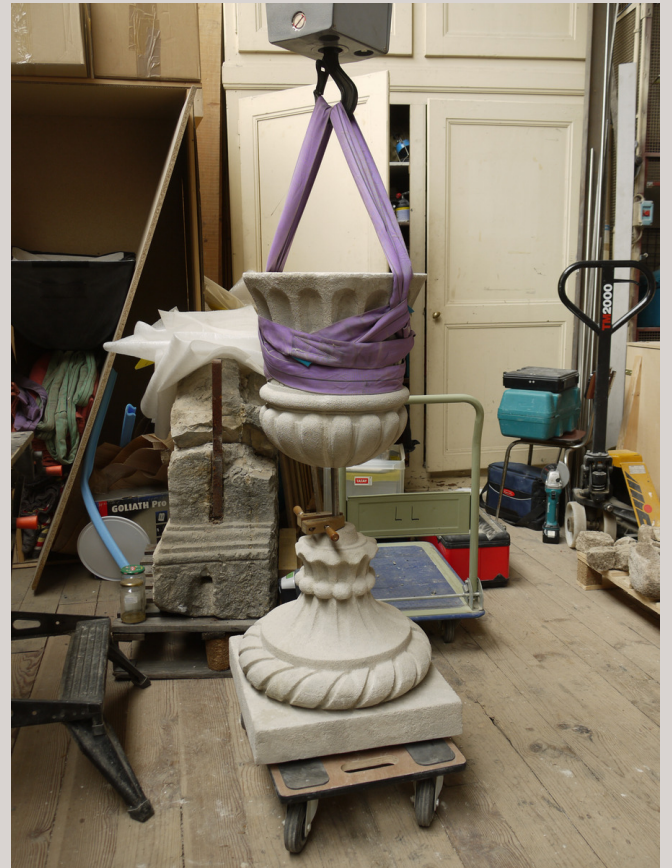
Mise en place du goujon en acier inoxydable
