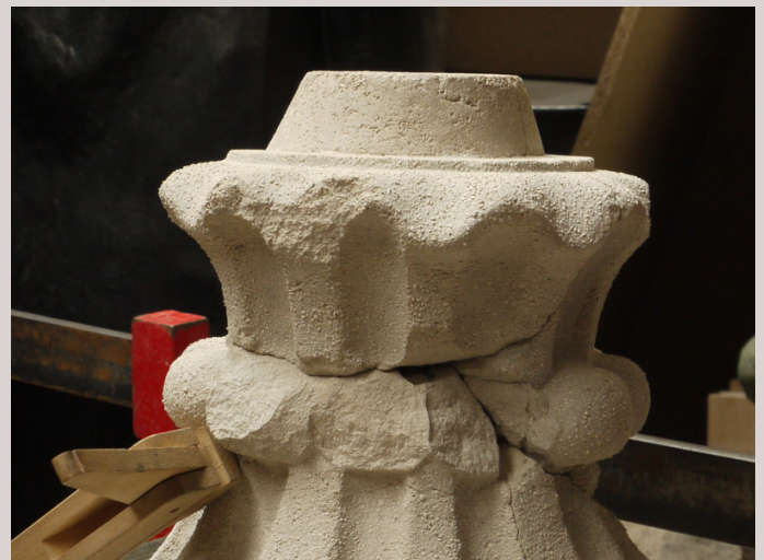
8. Après collage, des manques subsistent
