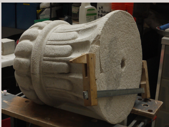
5. Serrage avec un serre-joint
