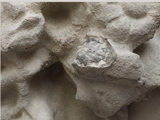
4. Trace de collage au mortier de ciment
