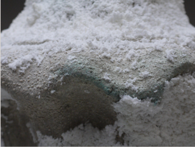
6. D'autres compresses seront nécessaires pour éliminer tout le colorant
