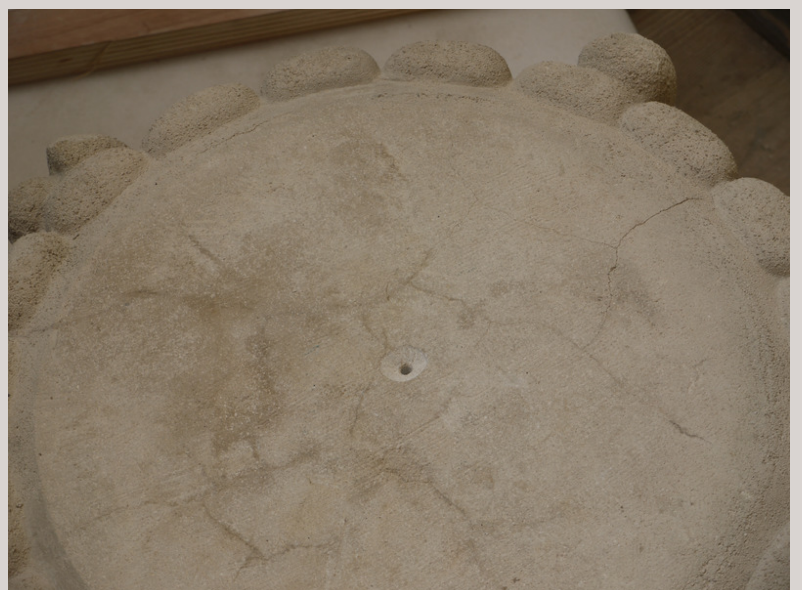
Le revers de la corbeille est percé pour y insérer l'extrémité du goujon inox
