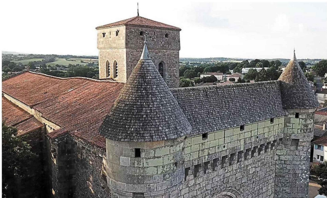
Une vue de la toiture et du clocher de l'église du Boupère (Vendée), qui concentrent la majeure partie des travaux envisagés par la commune. Ils ne devraient a priori pas engager sa fermeture. Le lieu de culte accueille une messe par mois et se visite toute l'année avec des audioguides.
