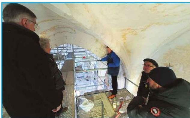
Visite de chantier à l'église Saint-Aignan le 1 er mars 2023.
