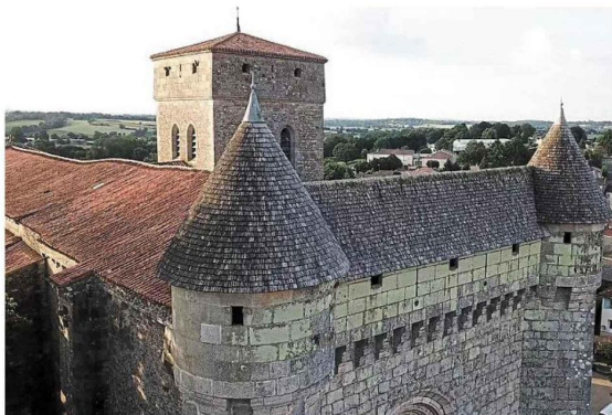
Une vue de la toiture et du clocher de l'église, qui concentrent la majeure partie des travaux envisagés par la commune. | PHOTO : VILLE DU BOUPÈRE
