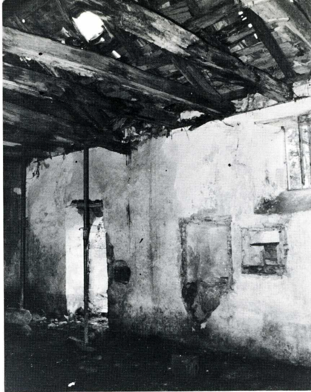
Le Riols (Tarn). Église Saint-Projet-de-la-Roque.
