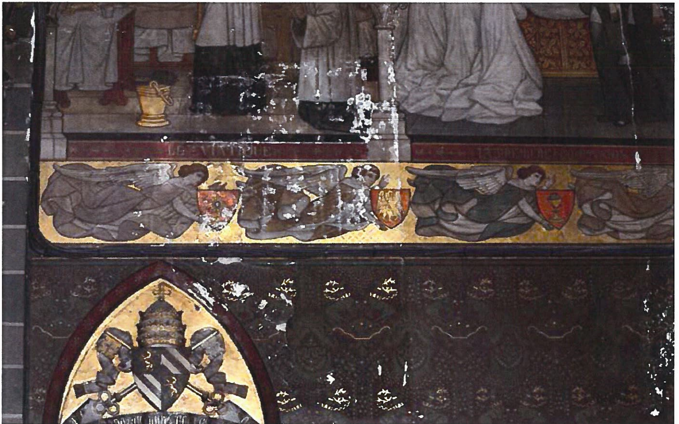
Choeur nord et choeur sud : deux frises de 8 anges : 2 400 euros chacune
