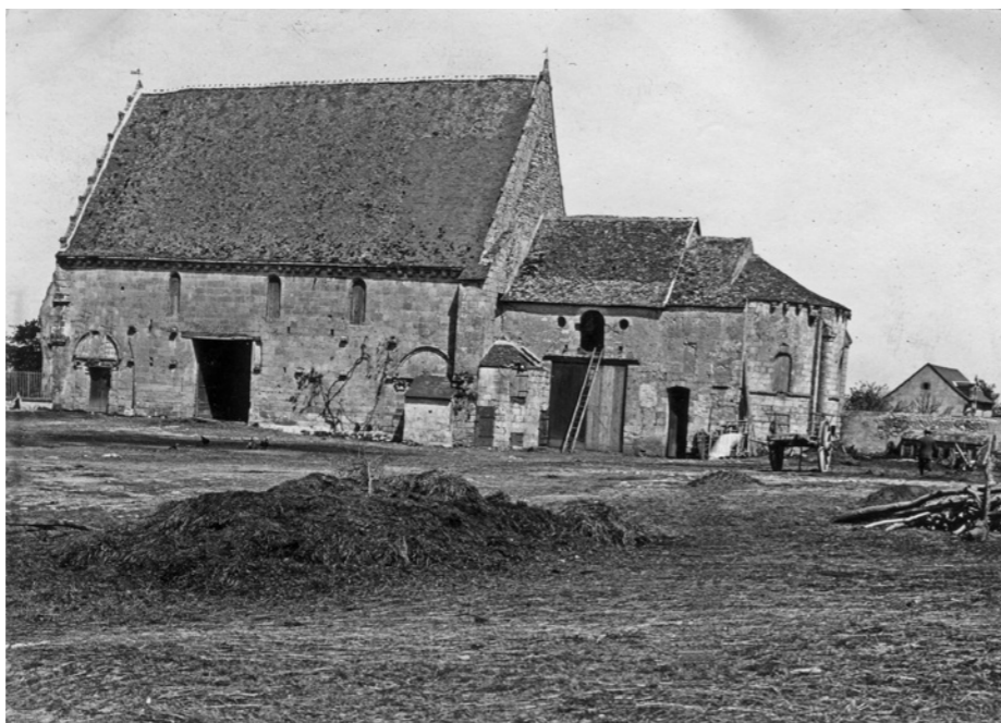
2. Façade sud, photo ancienne
