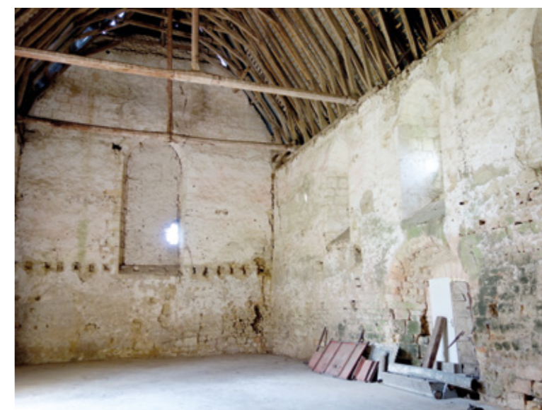
4. Nef (murs ouest et nord)
