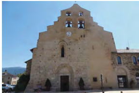
3 Église Sainte-Marie à Formiguères (66), 494 habitants XII e –XVI e siècles • Façade classée MH en 1913
