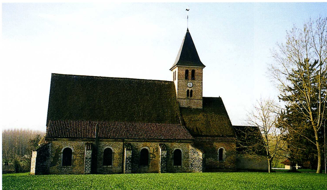
Sagy (Saône-et-Loire) Église Saint-Pierre Façade nord
