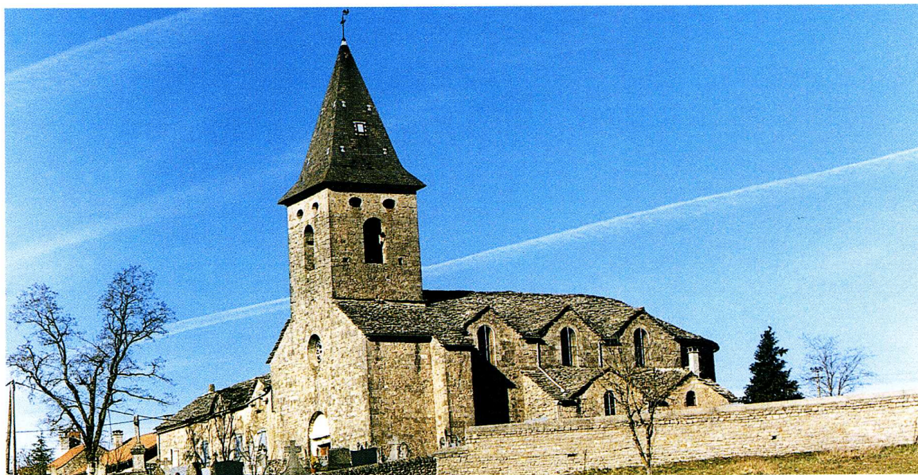
Saint-André-de-Vézines (Aveyron) Église Saint-André-et-Saint-Félix Vue sud-ouest
