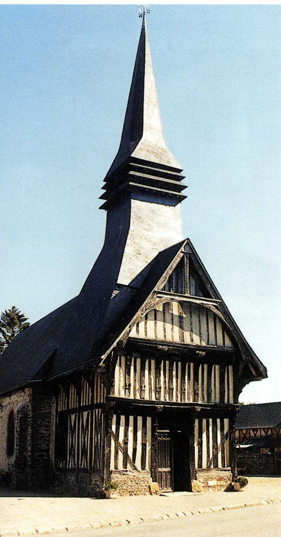
Saint-Aubin-de-Bonneval (Orne) Église Saint-Aubin Façade occidentale avec l'important porche de bois
