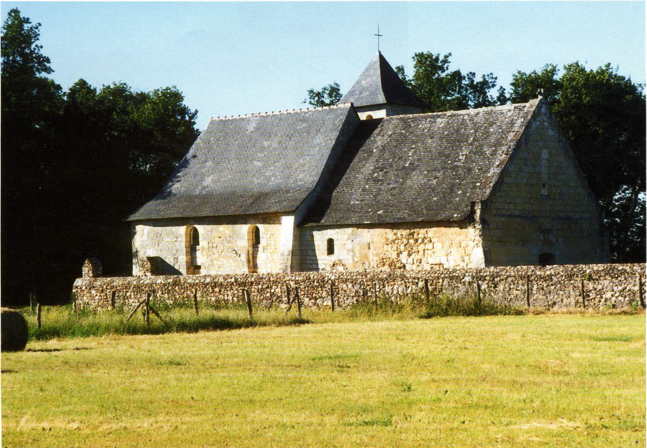
Saint-Georges-des-Sept-Voies (Maine-et-Loire) Église de Saint-Pierre-en-Vaux 3. Élévation nord
