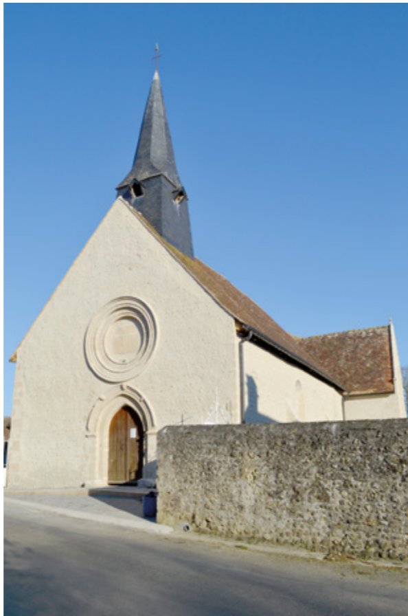
1. Façade sud-ouest après restauration
