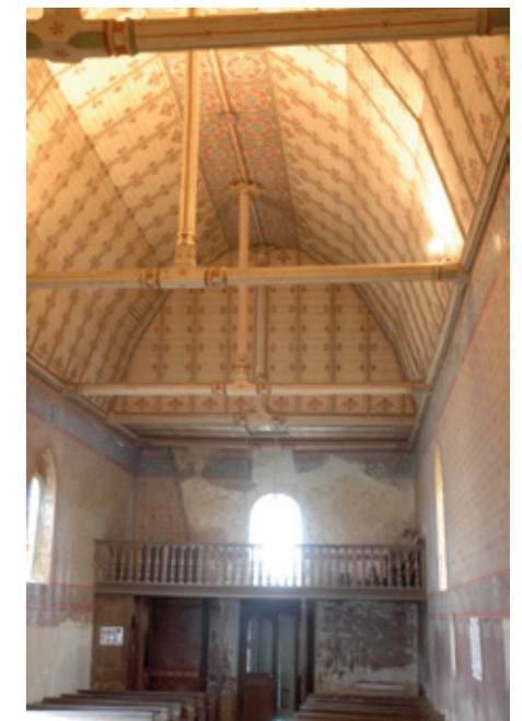
3. Vue intérieure vers l'entrée, voûte lambrissée peinte
