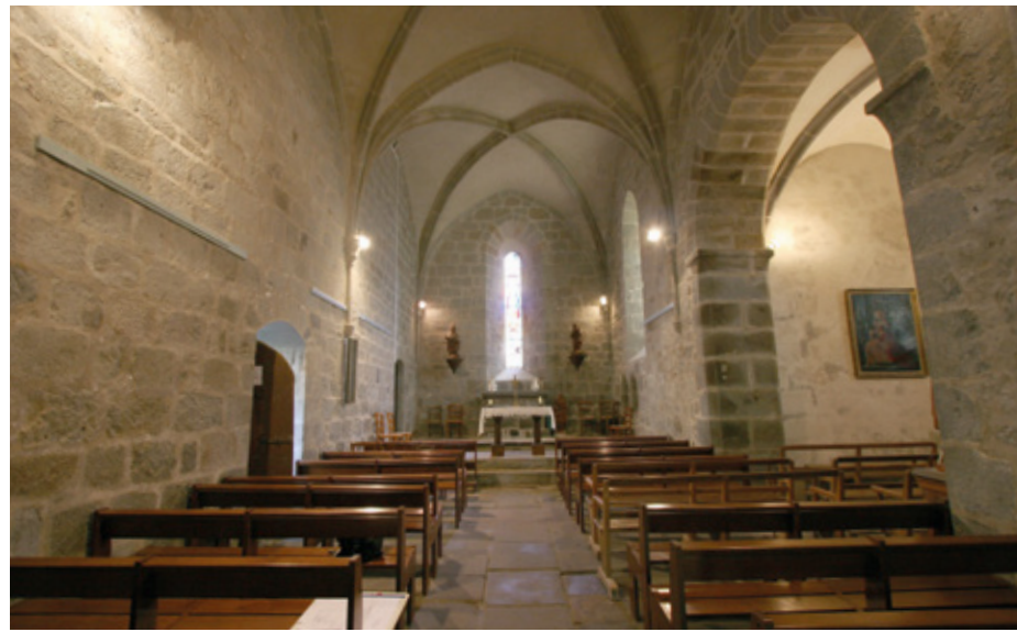
4. Vue intérieure vers le chœur
